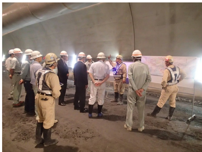
▲現場視察状況
